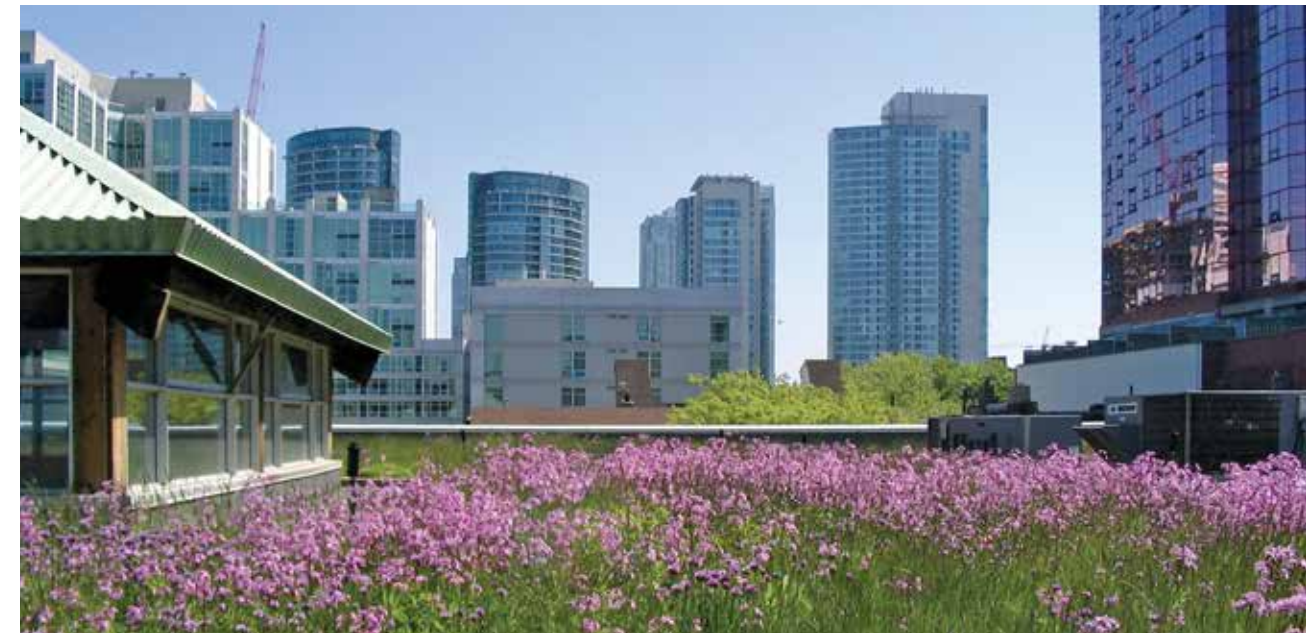
Figura 1: Terrazas verdes en edificios
