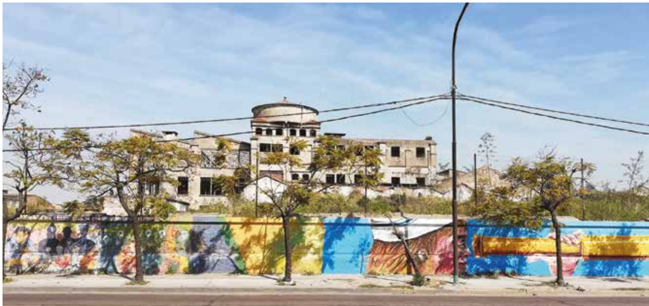
Figura 11: Predio de la ex-fábrica Campomar desde Av. Remedios de Escalada
