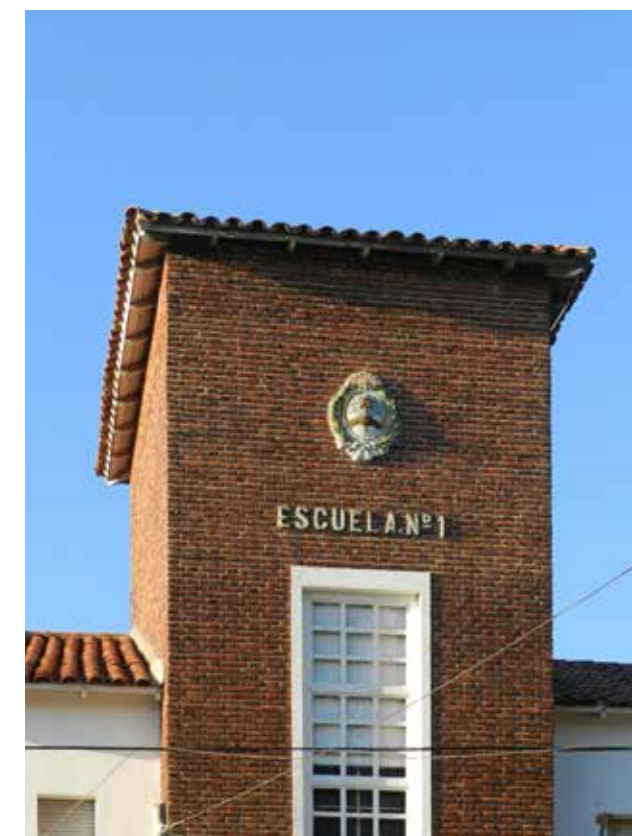
Figura 3: Escuela N°1 de Lanús "Juan Bautista Alberdi, Villa Obrera
