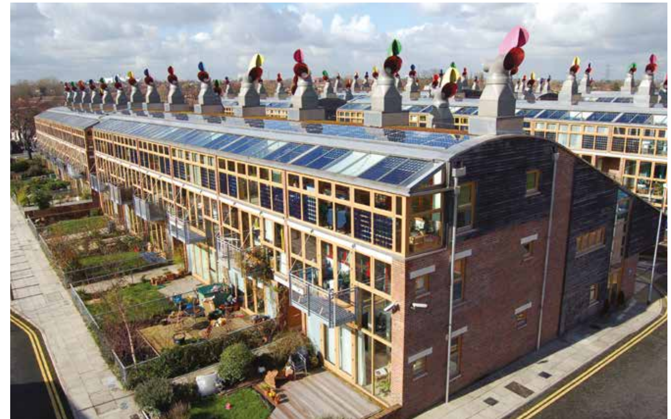
Figura 17: Edificios dotados de paneles solares fotovoltaicos y chimeneas de ventilación natural. Proyecto Beddington Zero Energy Development (BedZED) en Sutton (Londres, Reino Unido). Fuente: The Creative Commons Attribution 2.0 Generic license/ Attribution: Tom Chanc
