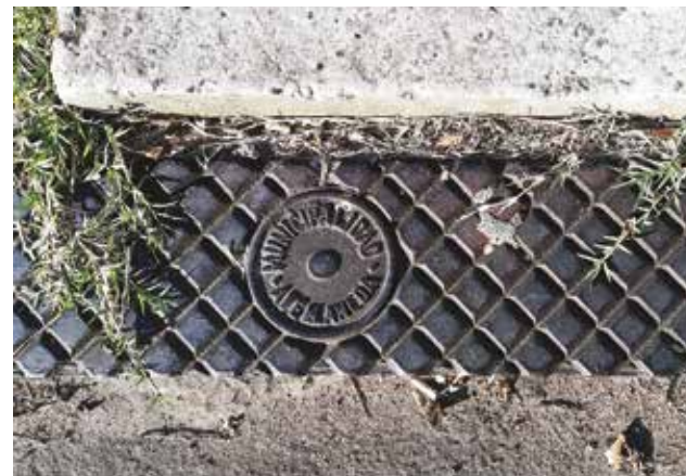
Fundición de frente de alcantarilla (boca de tormenta) en Lanús Este, donde se puede apreciar “Municipalidad Avellaneda”
