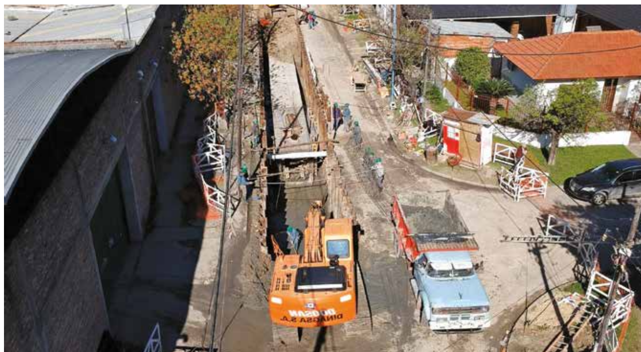
Figura 4: Obras en ejecución de la cuenca Olazábal, fundamentales para mitigar las inundaciones en la ribera de Villa Caraza, Jardín y Diamante Fuente: Secretaría de Desarrollo Urbano.
