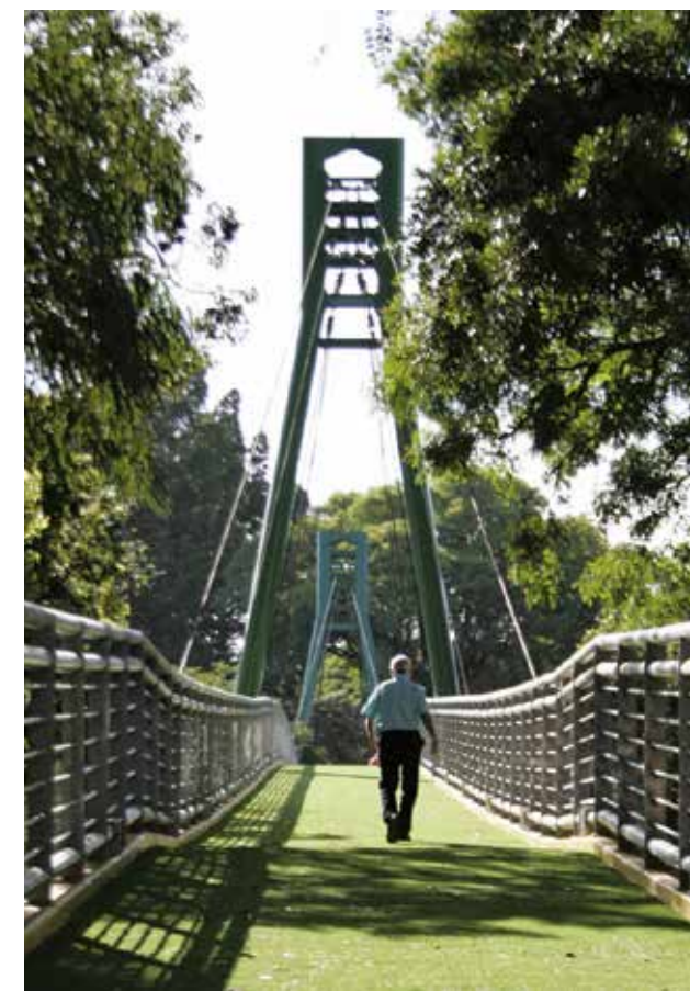
Figura 11: Puente peatonal Dorrego
