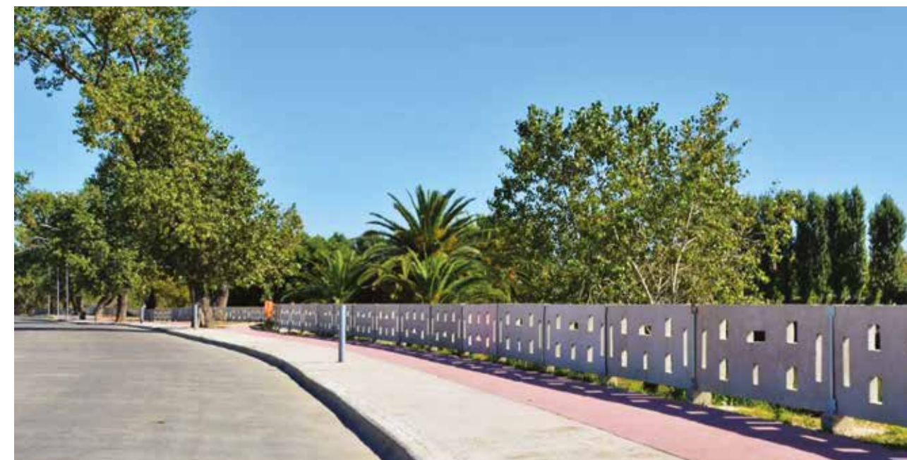
Figura 10: Estado actual de las obras de la costa de Valentín Alsina en las cercanías del puente.
